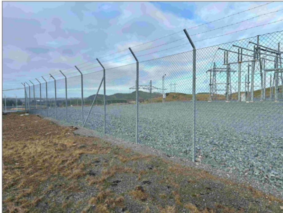
Figur 5-12 Utførelse av høyspentgjerde. Kilde: Statnett, Fagrafjell transformatorstasjon
