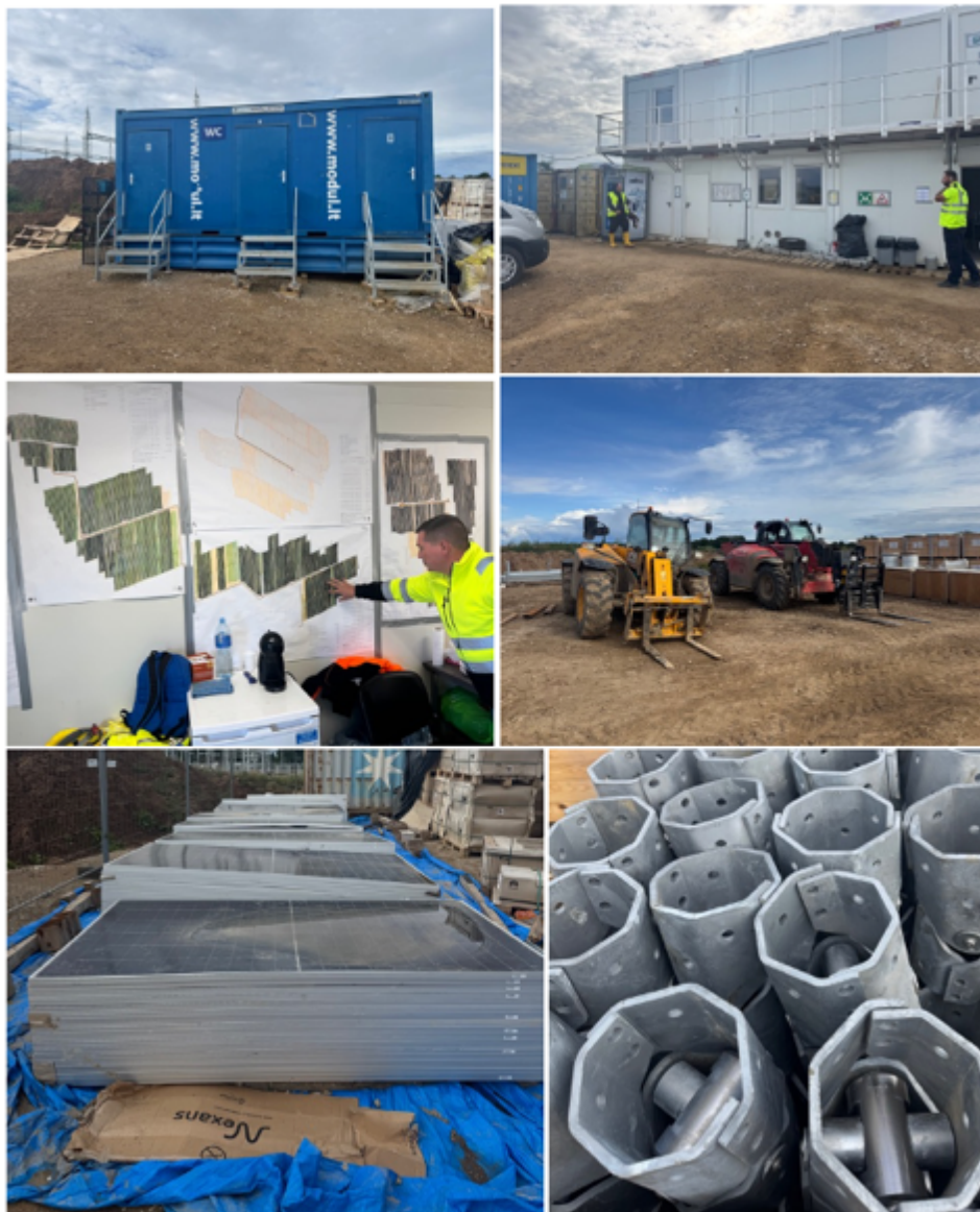
Figur 6-1 Bilder som illustrerer riggområde og utbygging av solkraftverk, Kilde Energeia AS
