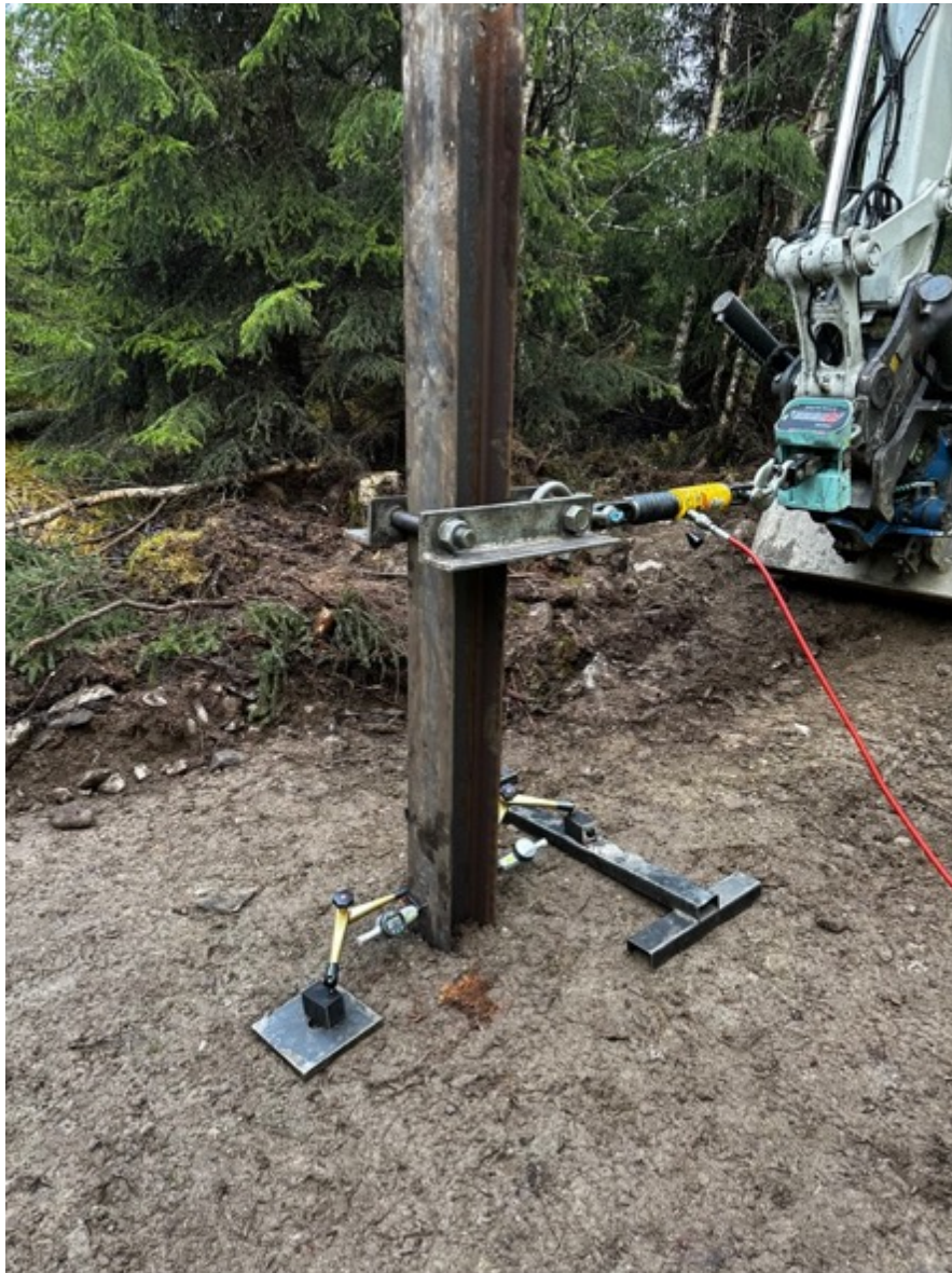
Figur 4-2 Bilde av pull-out-testing av bakke på Seval Skog, foto Energeia AS
