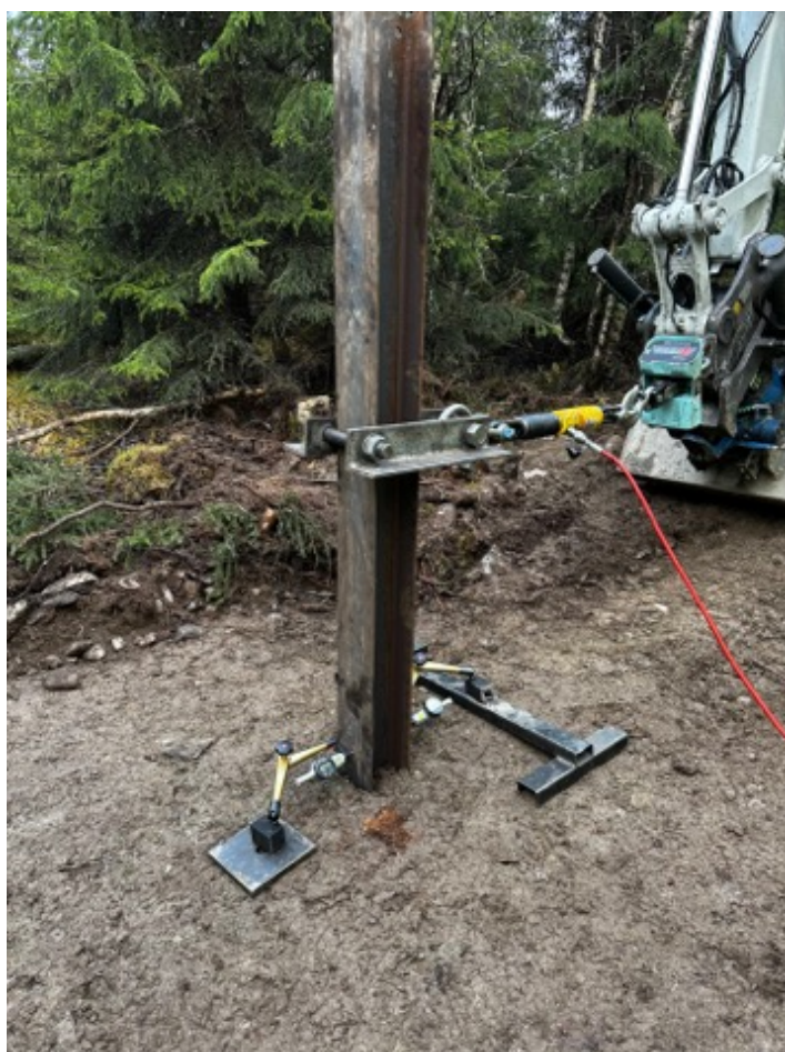
Bilde fra pull-out-test i planområdet på Seval Skog. Kilde Energeia AS
