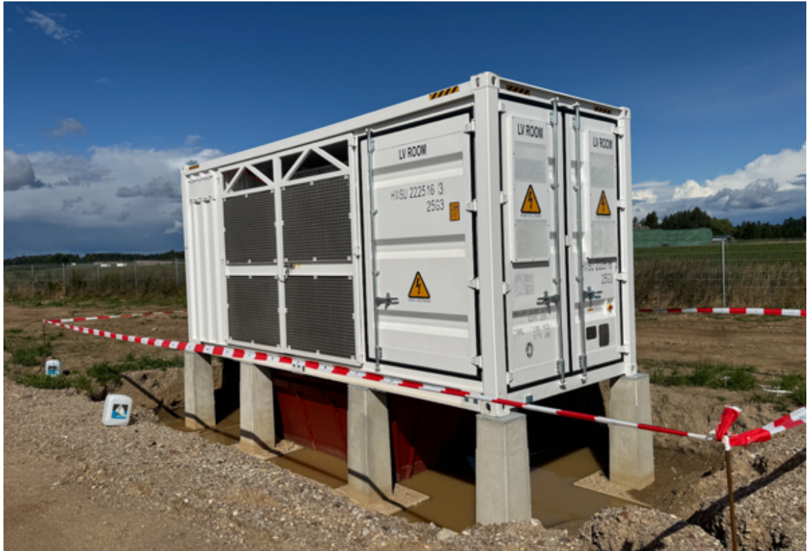
Figur 5-5 Illustrasjon av transformatorhus og nettstasjon med oljeoppsamler i bygget. Kilde Energeia AS
