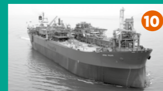
10 FPSO POLVO, PETRORIO
