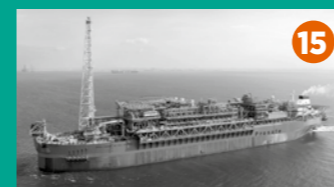
15 FPSO CIDADE DE SÃO MATEUS, PETROBRAS
